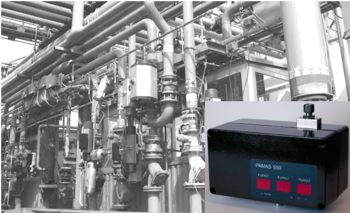
KUVA 2: Online-hiukkaslaskin mittaa öljyjärjestelmän hiukkasmääriä jatkuvasti
