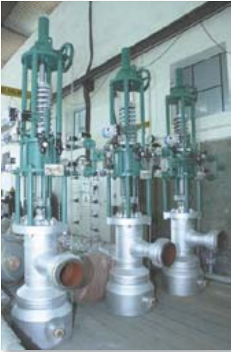
Kuva 1: Pulttikantaisia Reduktioventtiileitä.
